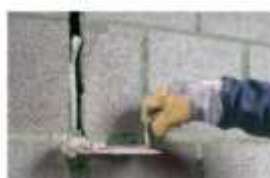
Corretto riempimento delle tracce impiantistiche.
