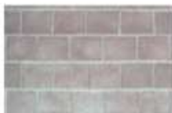
Corretto: presa dei blocchi con malta nei giunti orizzontali e verticali.
