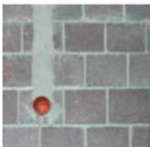
Parete divisoria con ponte acustico dovuto alla presenza di cavetto impiantistico.
