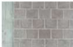
Giunto tra pilastro e muratura.
