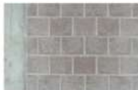
Giunto tra pilastro e muratura.
