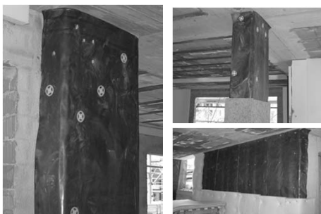
Isolamento strutture in c.a.
