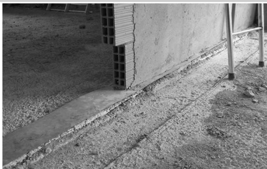
Posa della fascia Tagliamuro
