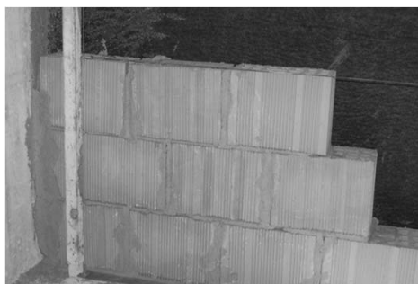
Posa della malta anche nei giunti verticali????
