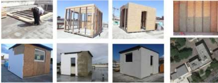
Costruzione test rooms (luglio – novembre 2011)
