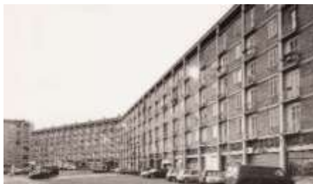
M. De Renzi, S. Muratori – Edificio a "boomerang" - Tuscolano II Roma
