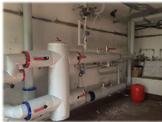
Istituto Comprensivo Statale Sebastiano Satta – Via della Vittoria Carbonia Lavori in Corso – Colibentazione Tubazioni in Centrale termica
