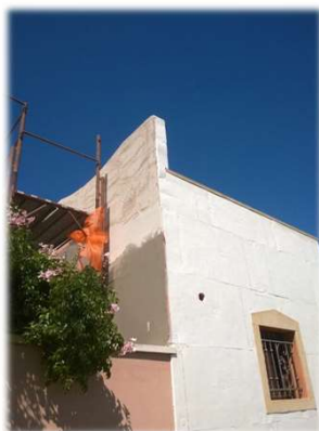
Cappotto esterno con pannelli in aerogel ( \lambda_D = 0,015 \text{ W/m}^2\text{K} )
