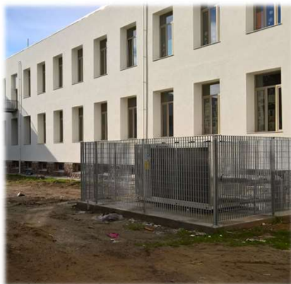
Istituto Comprensivo Statale Sebastiano Satta – Via della Vittoria Carbonia Lavori in Corso – Pompa di Calore
