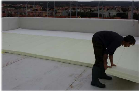
Istituto Comprensivo Statale Sebastiano Satta – Via della Vittoria Carbonia Lavori in Corso – Copertura – Tetto Rovescio isolato con XPS
