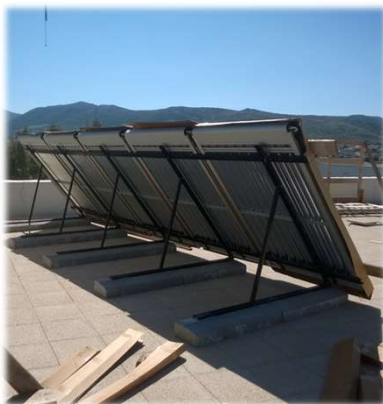
Istituto Comprensivo Statale Sebastiano Satta – Via della Vittoria Carbonia Lavori in Corso – Pannelli solari termici
