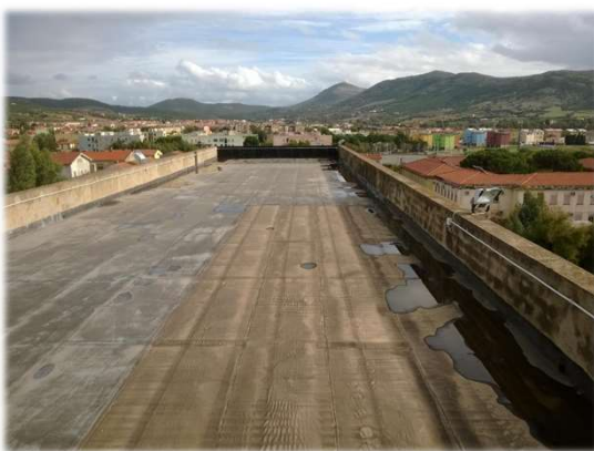
Istituto Comprensivo Statale Sebastiano Satta – Via della Vittoria Carbonia Situazione antecedente i lavori
