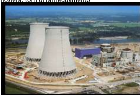
Torri di raffreddamento di una centrale termoelettrica: servono a smaltire il calore ceduto dal ciclo termodinamico dissipandolo nell'ambiente.
