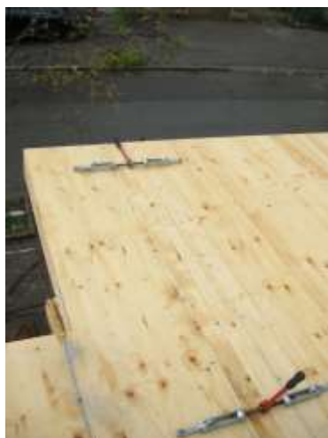
Alcune fasi dell'intervento
