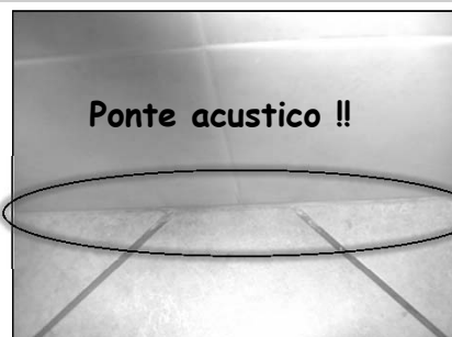
La posa del battiscopa / rivestimento (ceramico)
