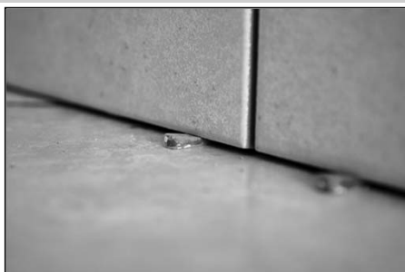
La posa del battiscopa / rivestimento (ceramico)
