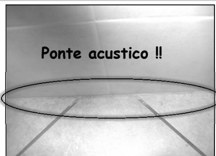
La posa del battiscopa / rivestimento (ceramico)
